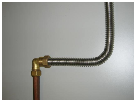
Montering af flexrør med pakning. Røret kan bukkes i forskellige vinkler.
